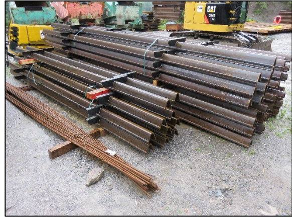
Bild 2: Stahl-Wasserablaufrienen des Typs «Jörimann»
