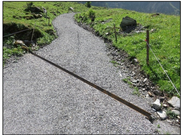
Bild 2: Sanierter Weg mit Querrinne.
