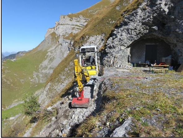
Bild 1: Wegganierung mit Kleinstschreitbagger. Bild 2: Vorbereitung Sprengarbeiten Geisstritt.
