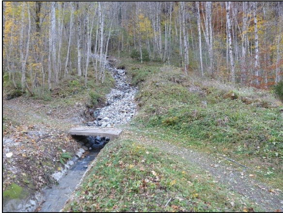
Bild 1: Abgelagertes Geschiebe vor dem Fussgängersteg nach dem Ereignis vom Oktober 2011.
