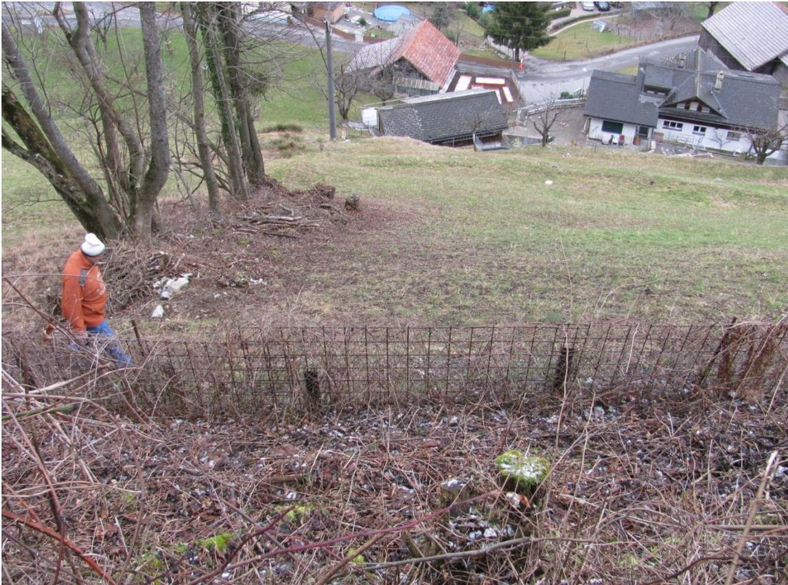
Abbildung 5: Bild des Steinschlagschutzzaunes im Anbruchgebiet.
